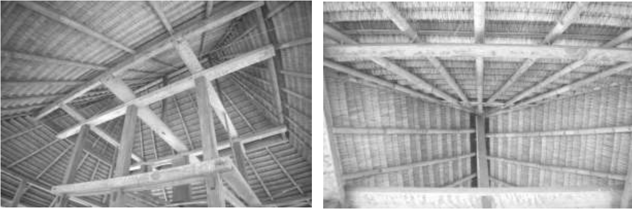
Gambar 8.15. rangkaian balok yang membentuk bale-mengina , struktur utamanya terbuat dari balok kayu, sedangkan strutur di atasnya yang bersentuan dengan elemen atap menggunakan bambu utuh. Adapun atapnya menggunakan ilalang yang diikatkan pada bilah bambu, pembatas dengan ruang luar menggunakan anyaman bambu (photo: Gatot Adi S.)
