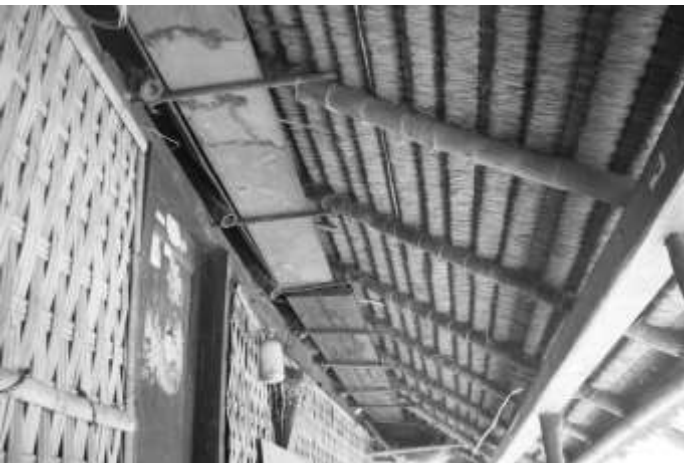
Gambar 8.11. suasana di dalam cirap, dapat menikmati susunan atap ilalang sang diikat pada bilah bambu (photo: Gatot Adi S.)
