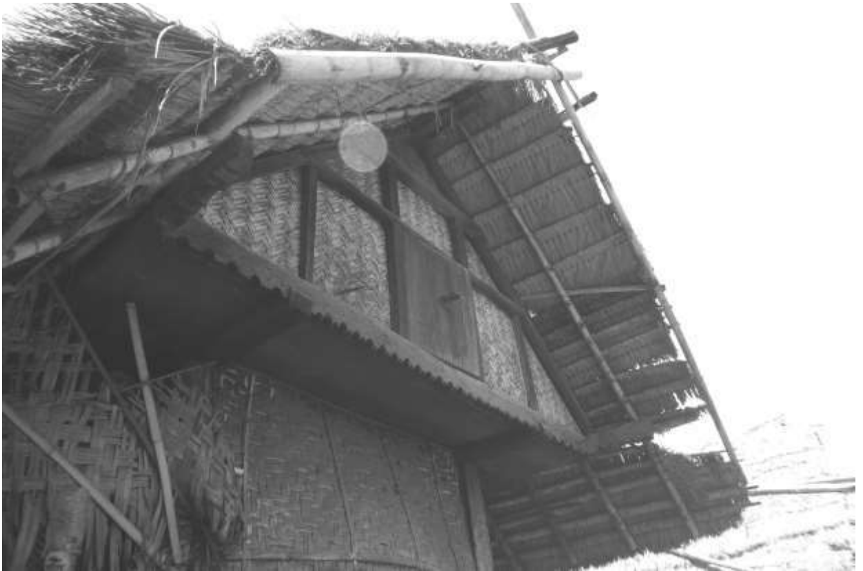
Gambar 8.23. pintu untuk memasukkan hasil panen di sambi , ada sedikit ornamen dihadirkan pada balok melintang di bawah pintu sambi (photo: Gatot Adi S.)
