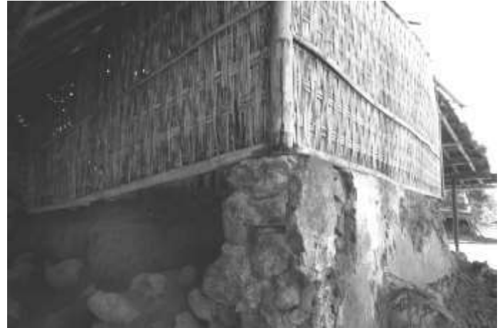
Gambar 9.8. Runtuhnya timbunan tanah di BT Beleq-Sembalun (photo: Gatot Adi S.)
