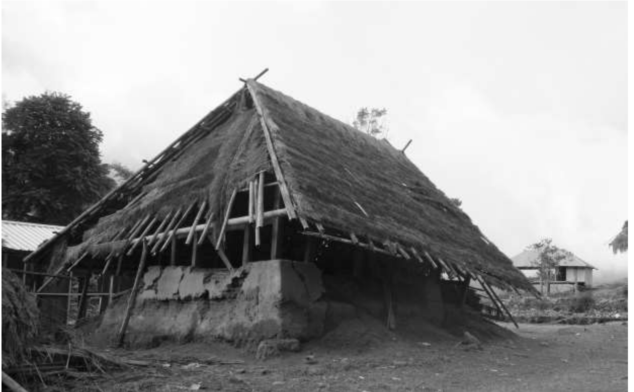
Gambar 6.9. bale-tani yang runtuh karena gempa di rumah adat desa Beleq-Sembalun(photo: Gatot Adi S.)
