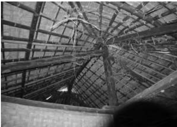
Gambar 3.15. (A) menunjukkan dua kuda-kuda yang digunakan di dalam bale-bontar beleq , dimana sistem dari kuda-kudanya seperti kuda-kuda konvensional sekarang; (B) Suasana di sesangkok bale-bontar beleq , digunakan untuk bersosialisasi bersama, bisa juga digunakan untuk menerima tamu, suasananya sangat rindang seperti duduk di bawah pohon besar. (photo: Gatot Adi S.)
