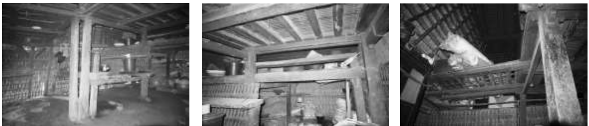
Gambar 8.14. Menunjukkan kerumitan rangkaian amben di dalam bale-mengina (photo: Gatot Adi)
